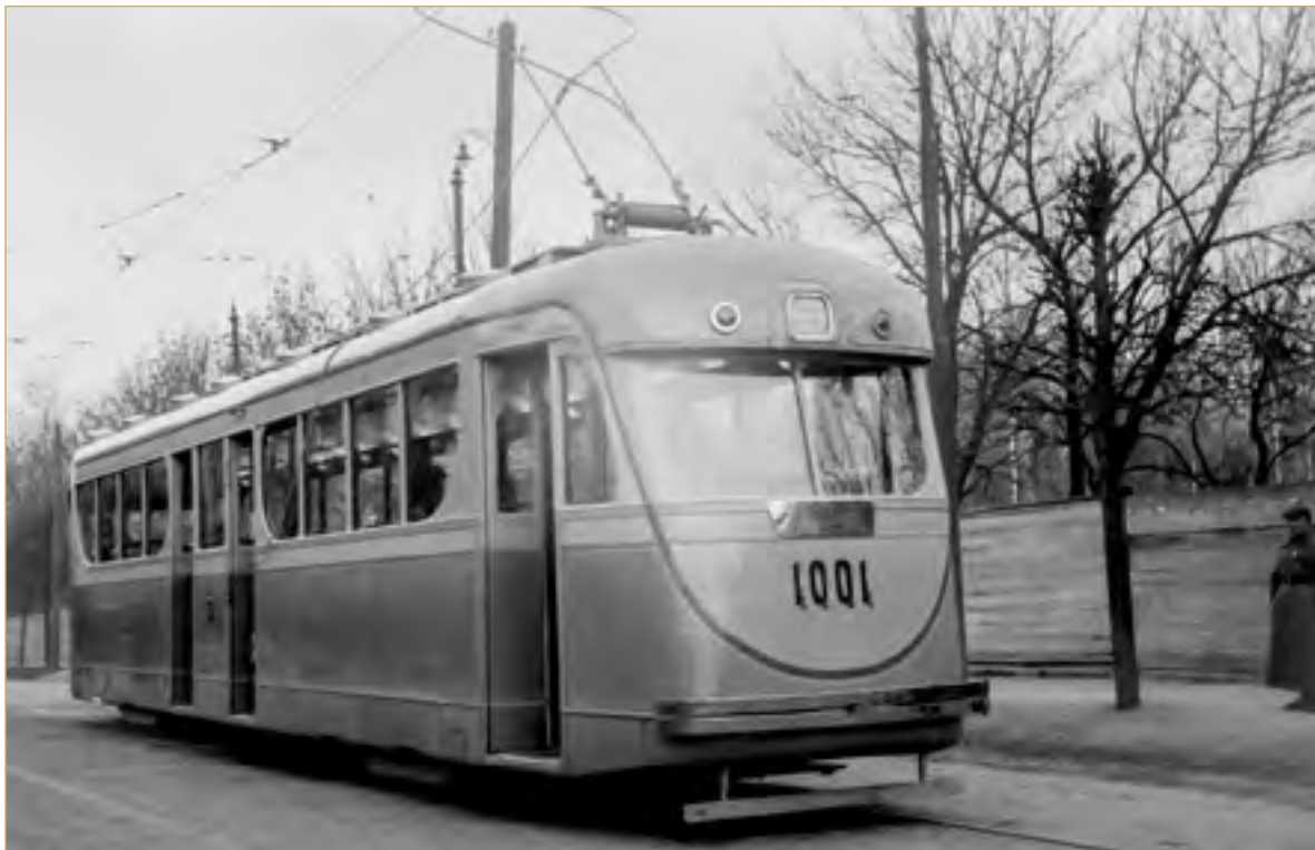
Моторный вагон опытного двухвагонного трамвайного поезда модели «М-36», выпущенного СВАРЗ. 1935 г. Главархив Москвы, ЦГА Москвы. А-0–87868
