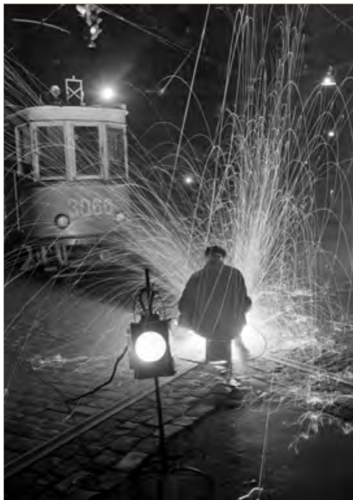
Ночной ремонт трамвайных путей. Сентябрь 1959 г. Фото Н. Рахманова, Е. Кассина. Главархив Москвы, ЦГА Москвы. А-1–8653
