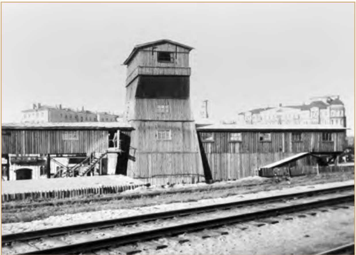
Шахта метрополитена в районе Каланчёвской улицы. 1940-е гг. ГЛАВАРХИВ МОСКВЫ, ЦГА МОСКВЫ. А-ФА-152П8
