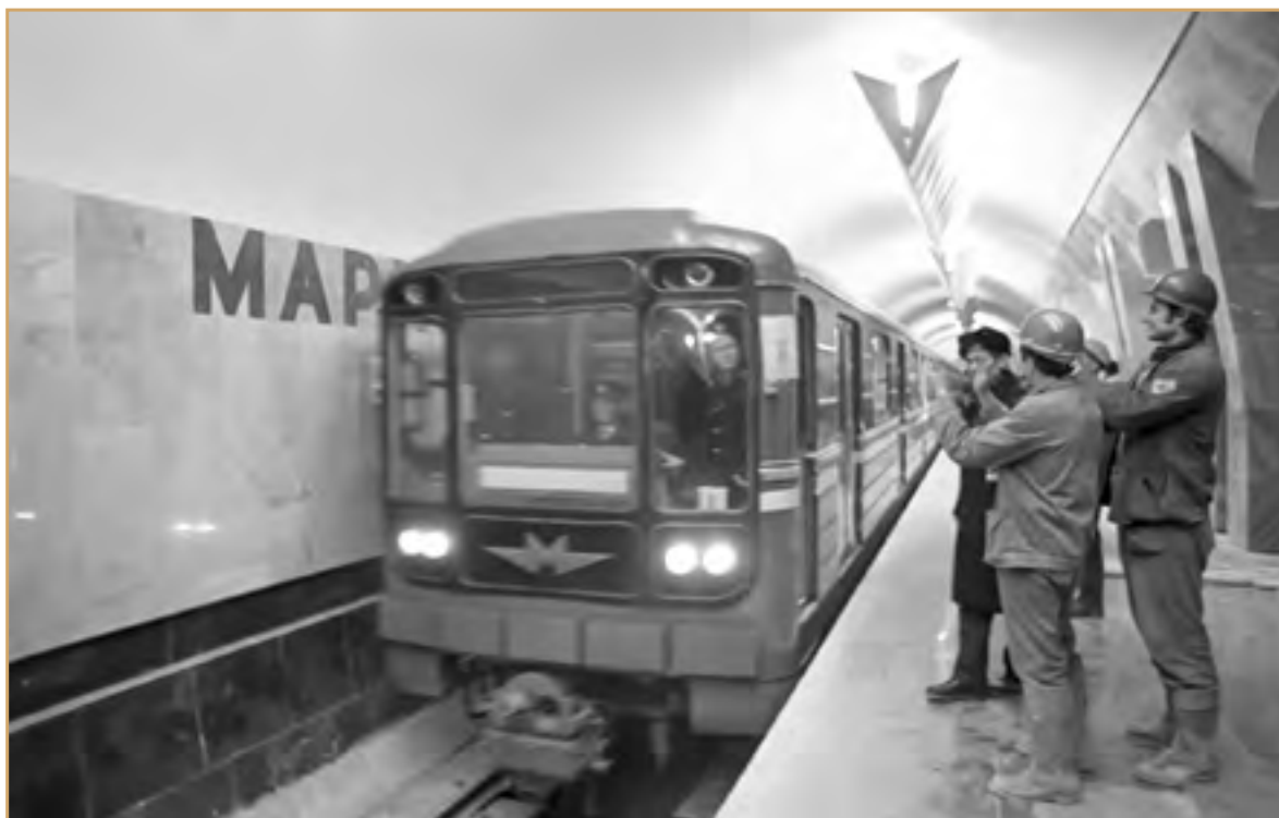
Пробный поезд на станции «Марксистская» перед сдачей в эксплуатацию Калининского радиуса. 17 декабря [1980 г.] Фото Г. Шпунькина. Главархив Москвы, ЦГА Москвы. А-0–35469
