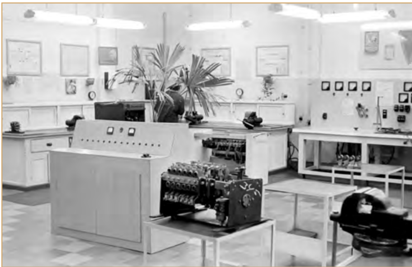
Приборы и оборудование электродепо «Красная Пресня». 1978 г. Фото Е. Самойлова. Главархив Москвы, ЦГА Москвы. А-О–43739
