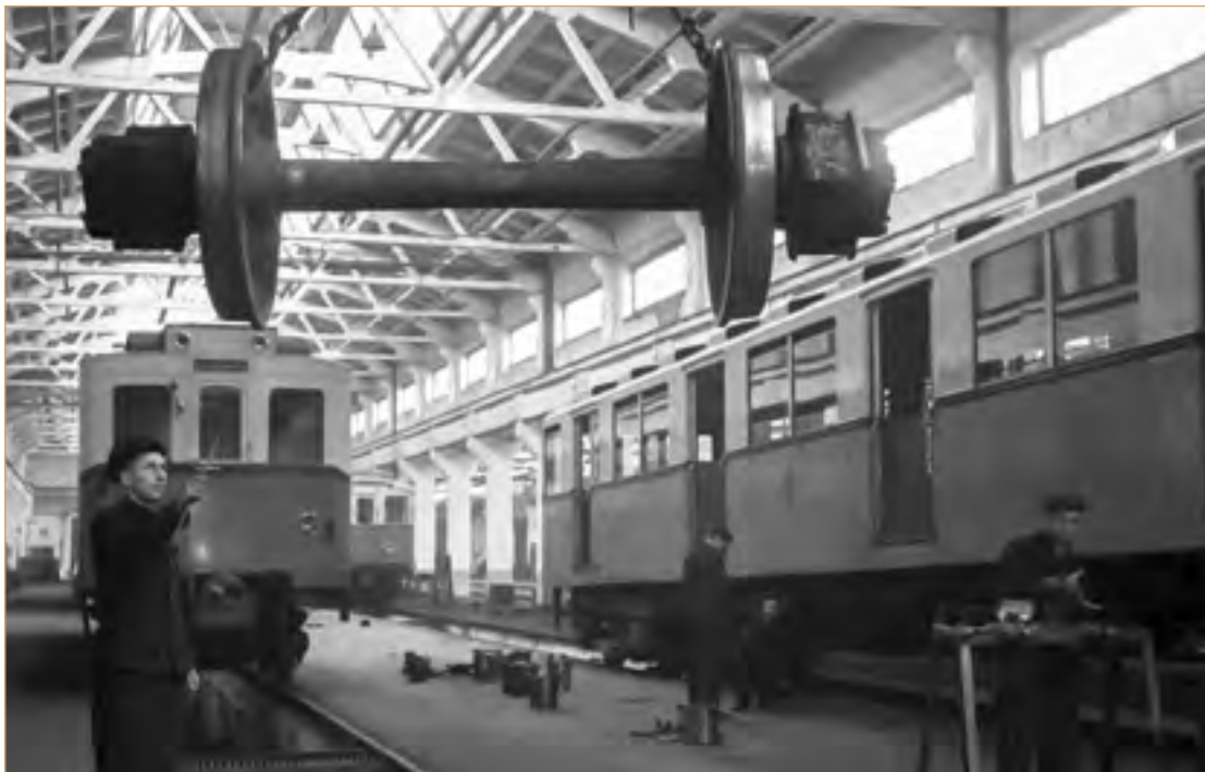
Техническое обслуживание и ремонт электропоездов в депо на станции метро «Сокол». 1948 г. Фото Г.Корабельникова. Главархив Москвы, ЦГА Москвы. А-0-74384
