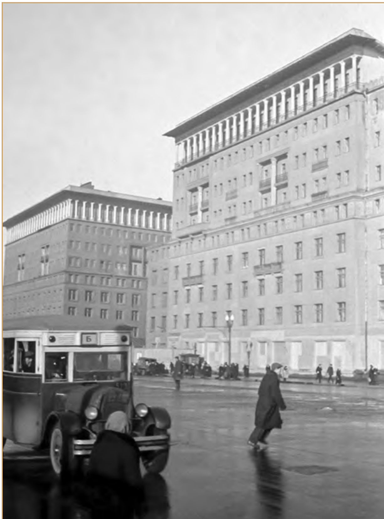
На улице Земляной Вал. Март – апрель 1935 г. Фото Б. Вдовенко. Главархив Москвы, ЦГА Москвы. А-0-78372
