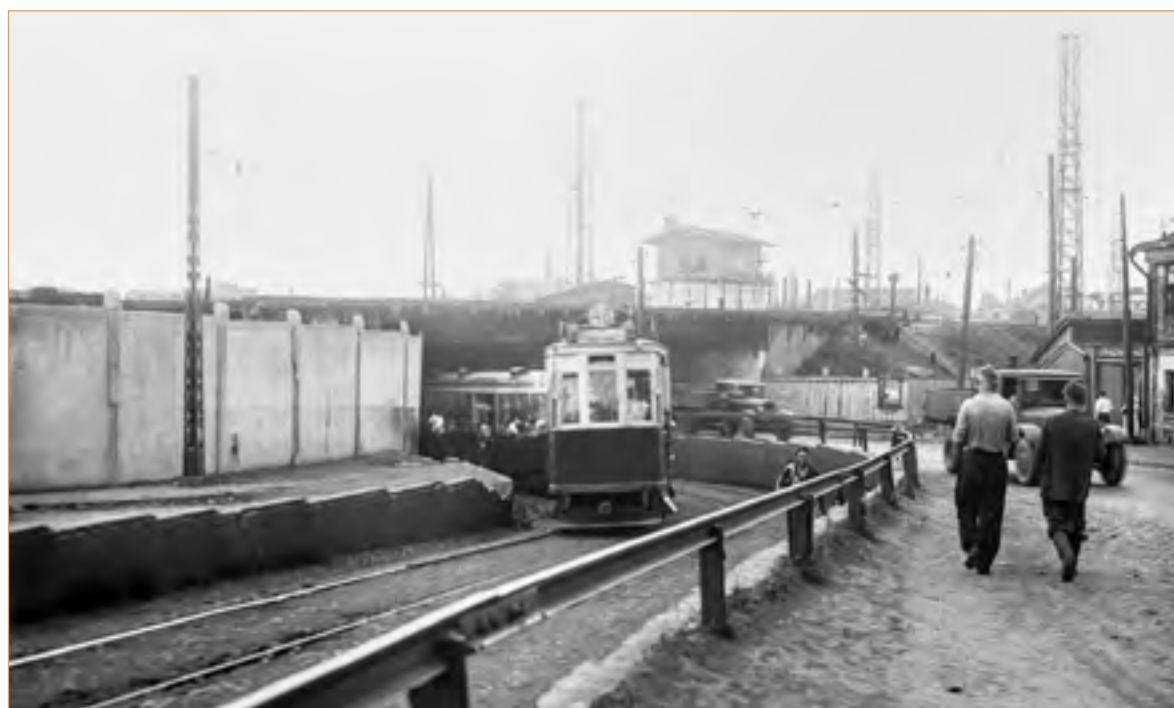
Трамвайные пути на шоссе Энтузиастов, на дальнем плане – путепровод Курской железной дороги. 1937 г. Главархив Москвы, ЦГА Москвы. А-2-6270
