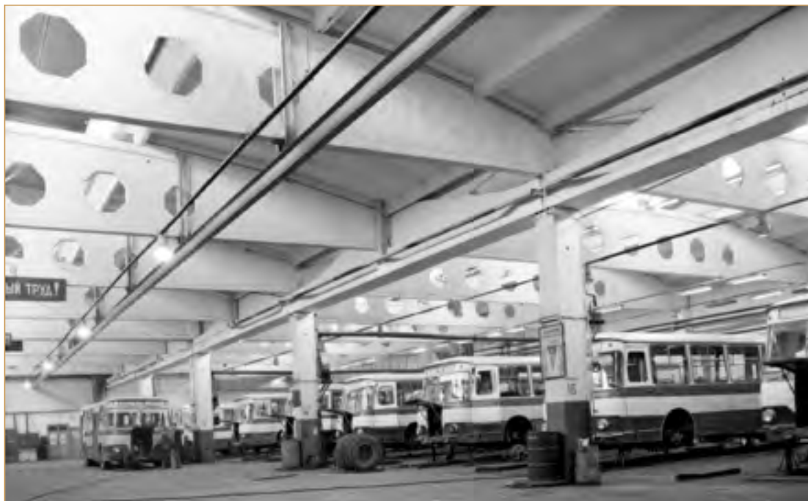
Ремонтный гараж 1-го автобусного парка. 1983 г. Фото М. Невматулина. Главархив Москвы, ЦГА Москвы. А-1-53963
