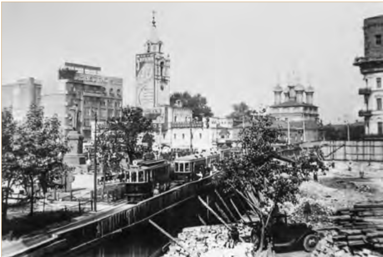
Пушкинская площадь во время реконструкции. [1934 г.] Фото Н. Грановского. ГЛАВАРХИВ Москвы, ЦГА Москвы. А-ФА-69П24
