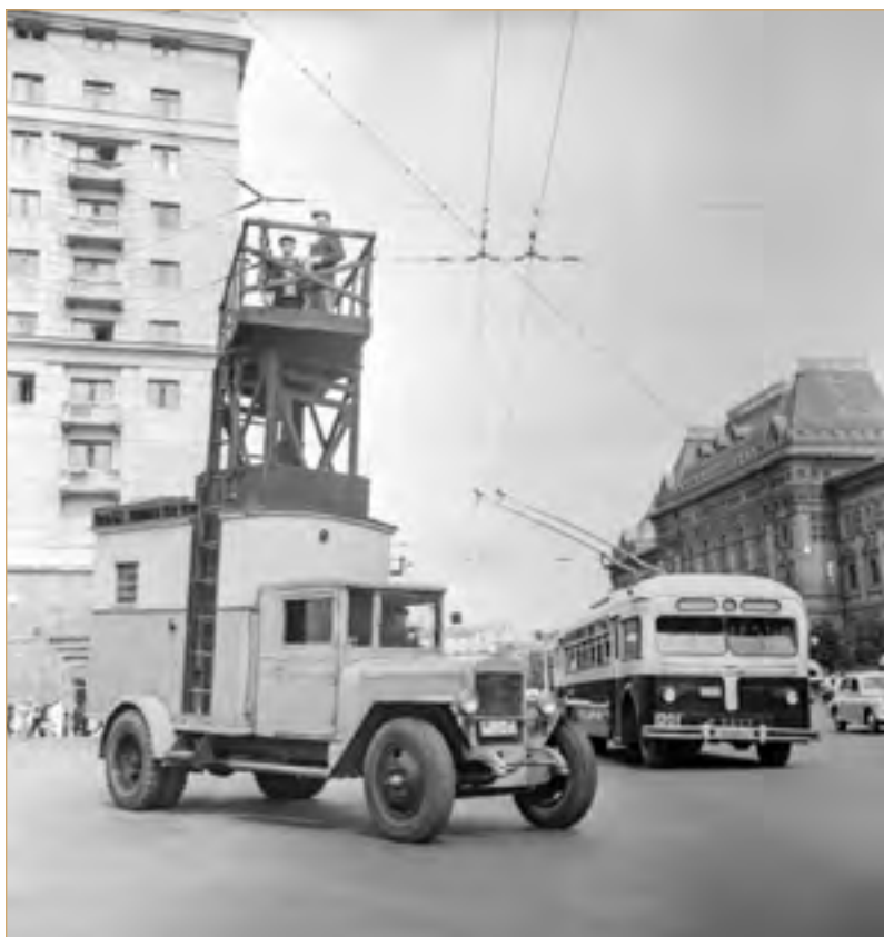
Ремонт контактной сети. Август 1955 г. Фото А. Чепрунова. Главархив Москвы, ЦГА Москвы. А-1-21187
