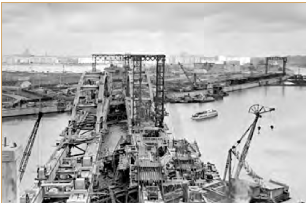
Строительство метромоста через Москву-реку в районе Ленинских гор. 1950-е гг. Фото Г. Корабельникова. Главархив Москвы, ЦГА Москвы. А-0–76231
