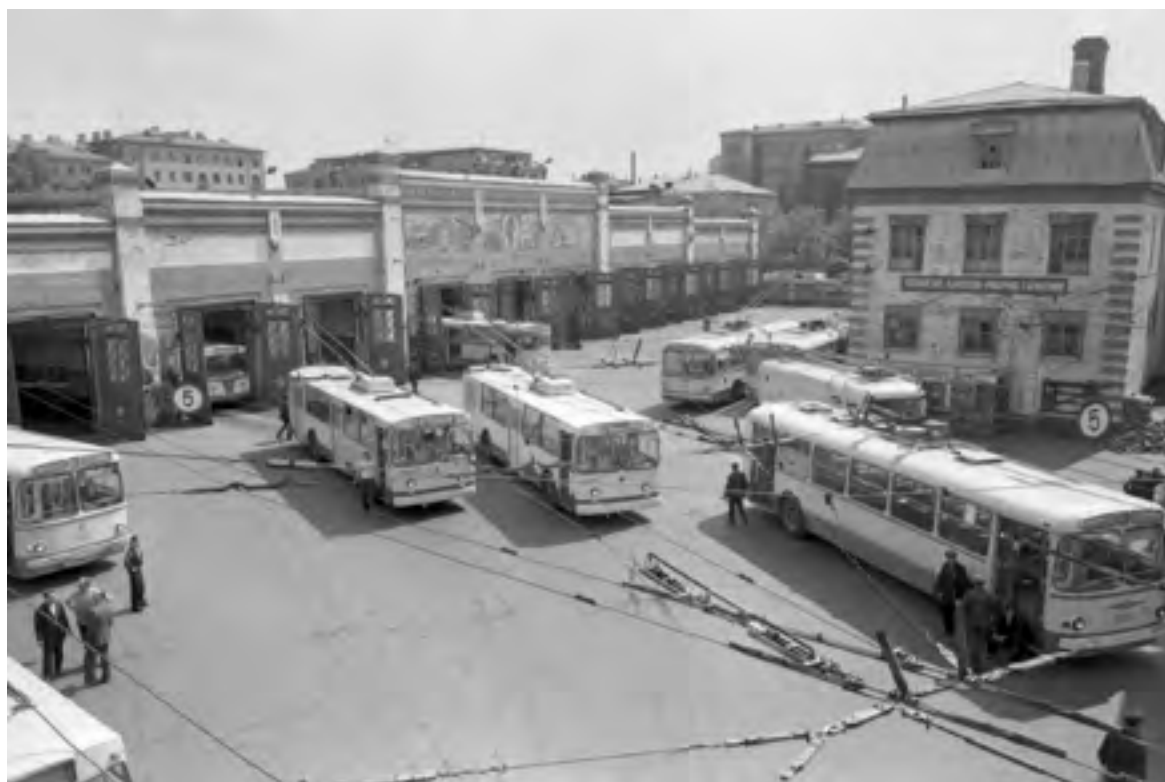
В троллейбусном парке им. П.М. Щепетильникова. 1975 г. Фото И. Бузова. Главархив Москвы, ЦГА Москвы. А-1 – 54106
