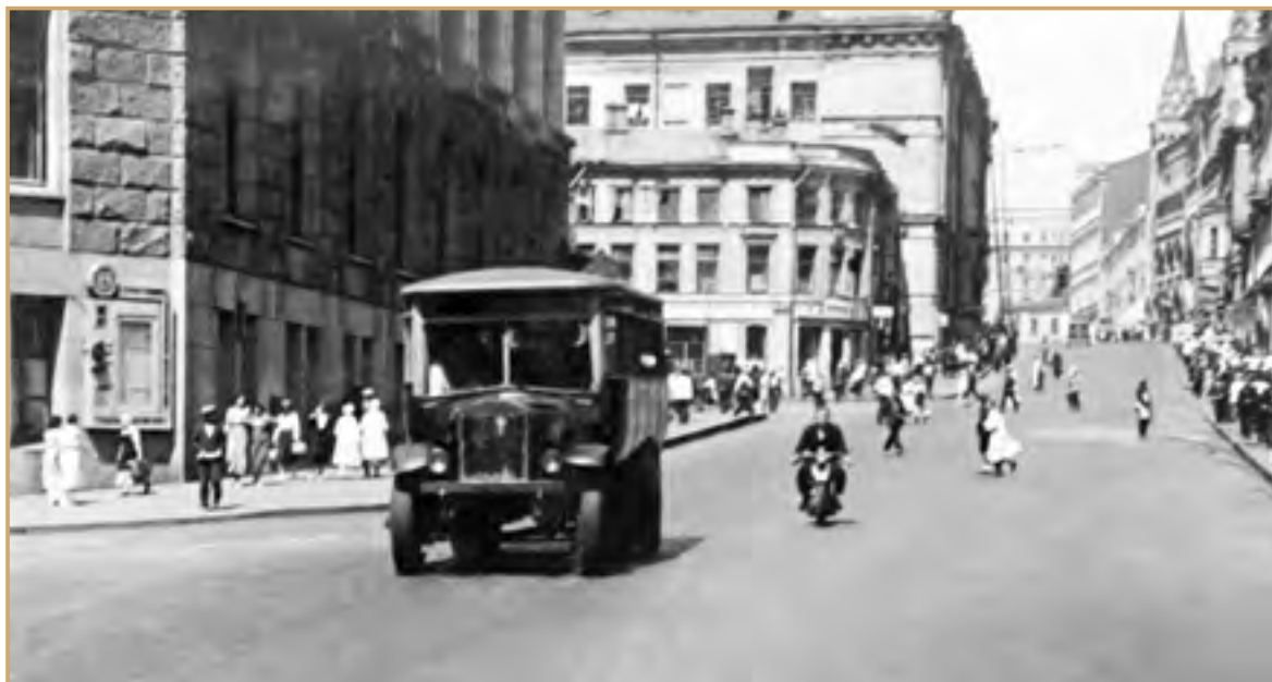
Улица Горького до реконструкции. 1936 г. Главархив Москвы, ЦГА Москвы. А-ФА-80П46
