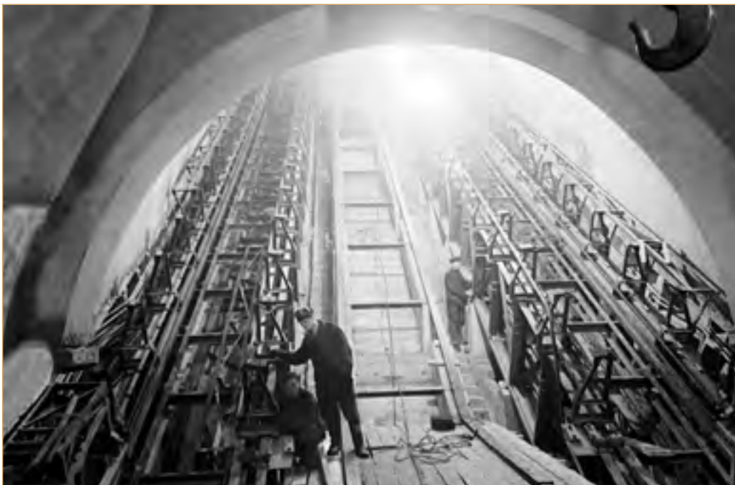
Монтаж эскалатора на станции метро «Киевская»-кольцевая. Октябрь 1953 г. Фото А. Столяренко. Главархив Москвы, ЦГА Москвы. А-0–27656
