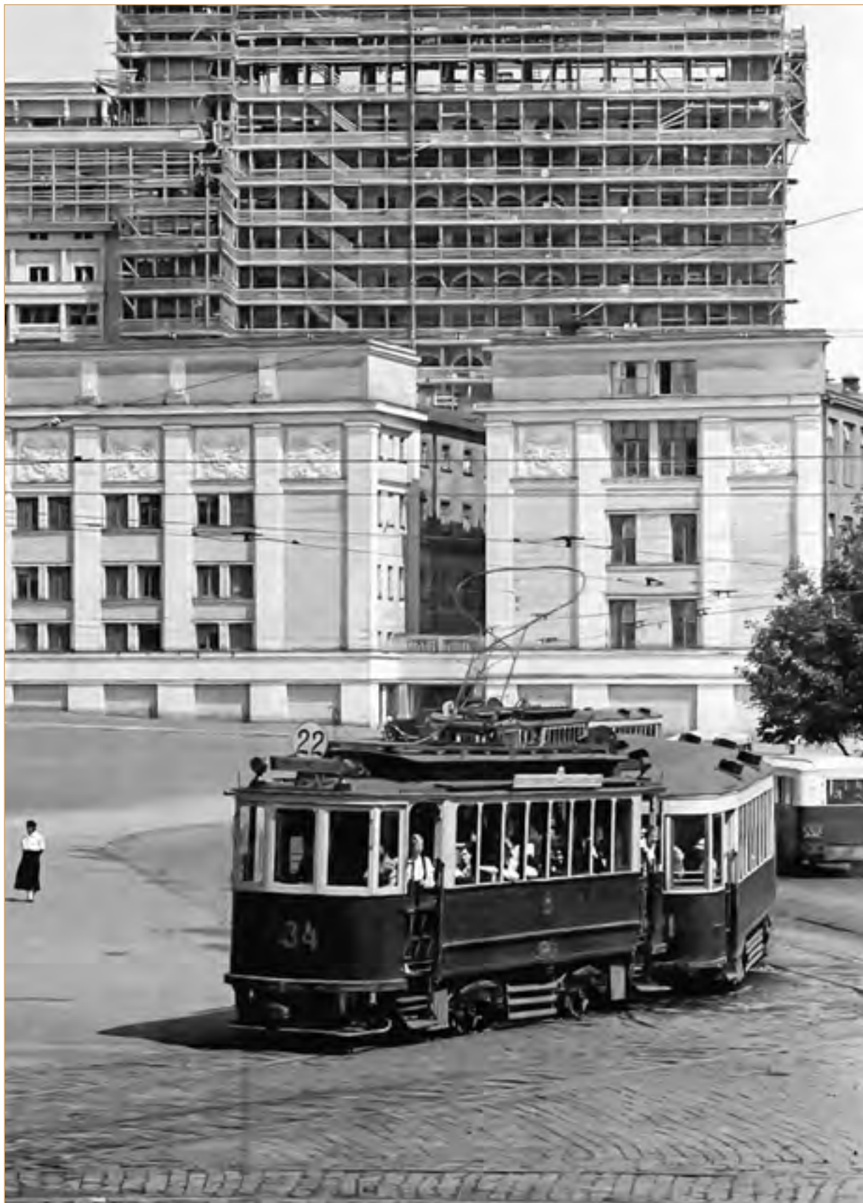
Трамвай 22-го маршрута перед строящимся зданием гостиницы «Москва». 1934 г. Фото Б. Игнатовича. Главархив Москвы, ЦГА Москвы. А-0-110778
