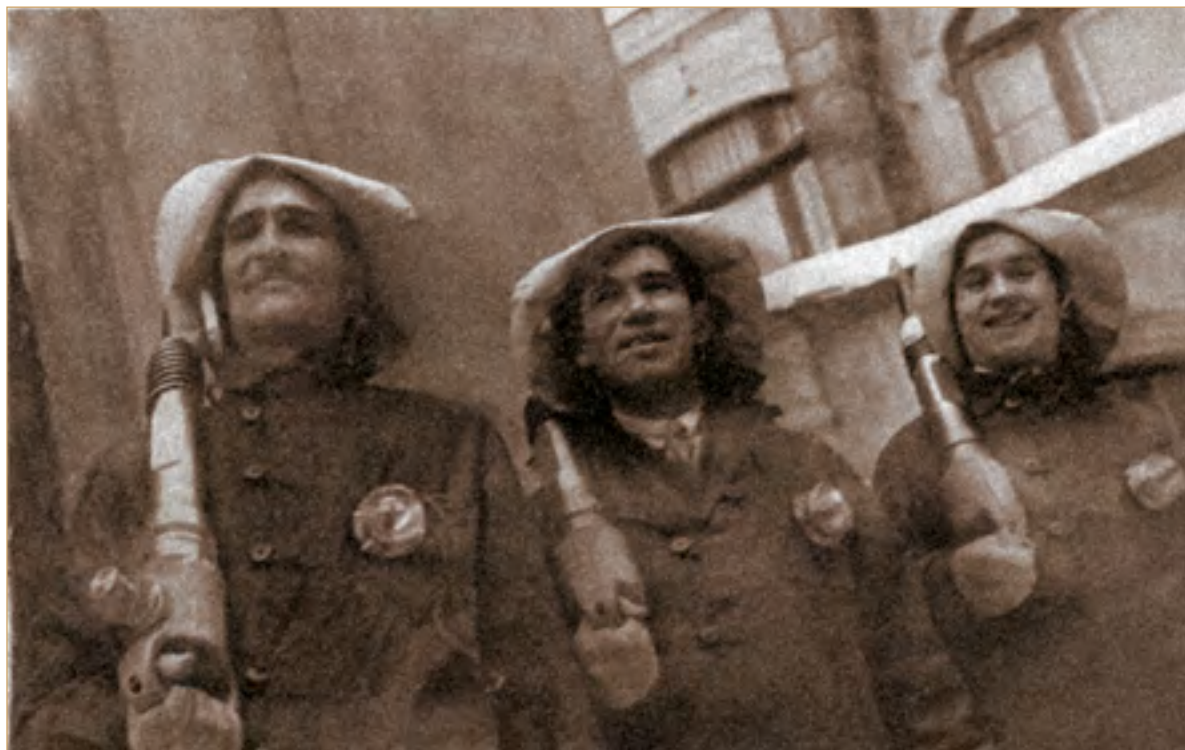
Строители Московского метро. [1933–1934 гг.] Главархив Москвы, ЦГА Москвы. Ф. Р-665. Оп. 1. Д. 291. Л. 11 об.
