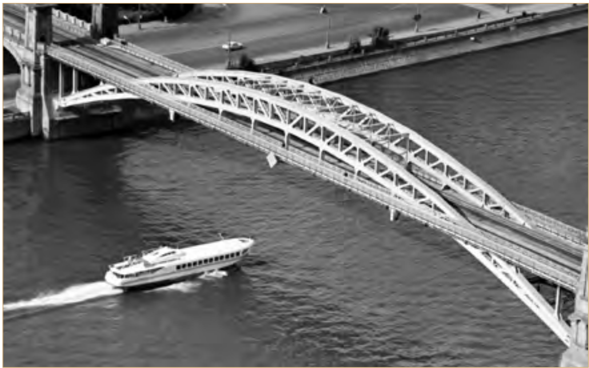
Вид на мост Окружной железной дороги через Москву-реку. 1982 г. Фото Б. Ярославцева. Главархив Москвы, ЦГА Москвы. А-0–112432
