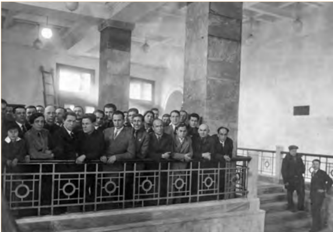
Строители станции метро «Охотный Ряд». 1935 г. Главархив Москвы, ЦГА Москвы. Ф. Р-665. Оп. 1. Д. 291. Л. 9
