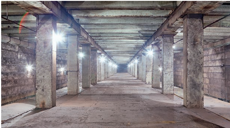
Станция «Спартак» до начала работ по достройке
